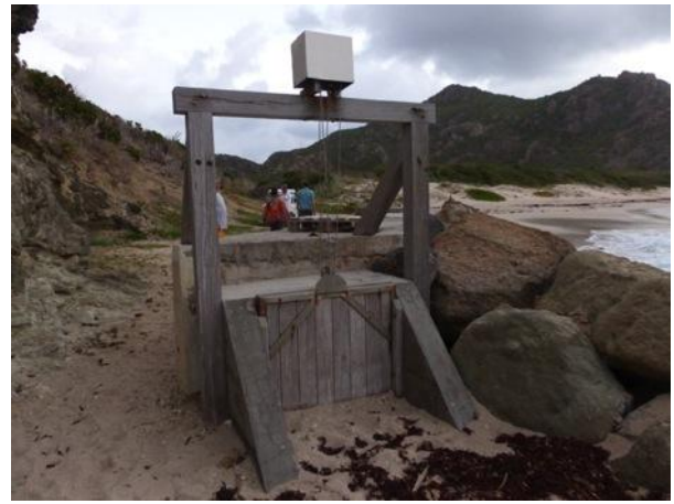
Figure 13 : Canal ensablé d'amenée d'eau dans la Grande Saline, extrémité vers la plage et trappe d'ouverture
