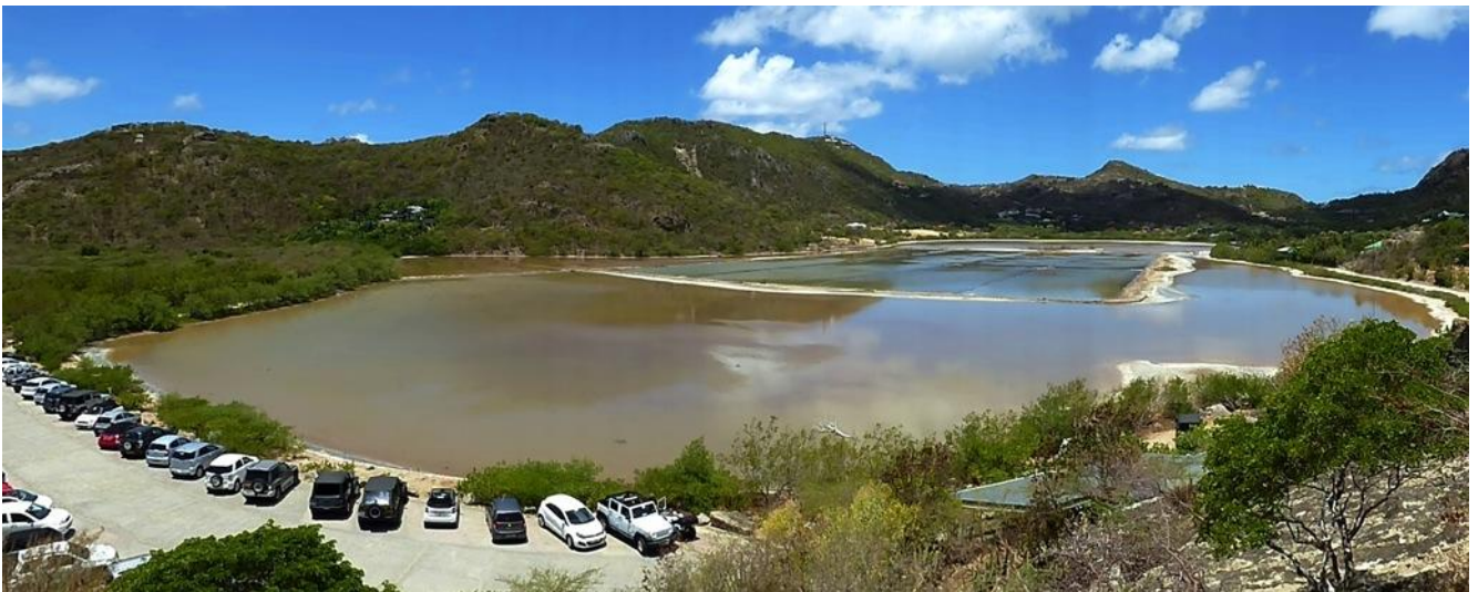
Figure 19 : Vue de la grande saline, du parking et du cordon boisé (source : Olivier Raynaud)
