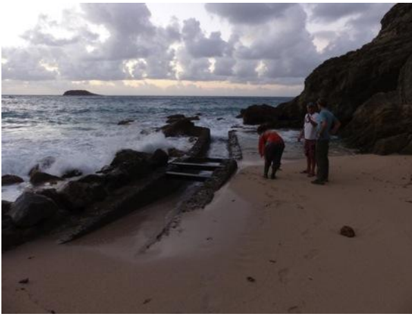
Figure 13 : Canal ensablé d'amenée d'eau dans la Grande Saline, extrémité vers la plage et trappe d'ouverture
