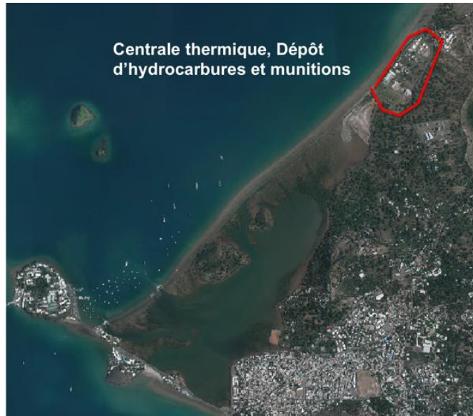
Figure 28 : Localisation de la centrale thermique, du dépôt d'hydrocarbures et de munitions
